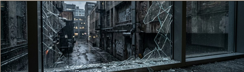
Evidencia 05: Cristalera de seguridad fracturada con apertura hacia el callejón de lluvia.
